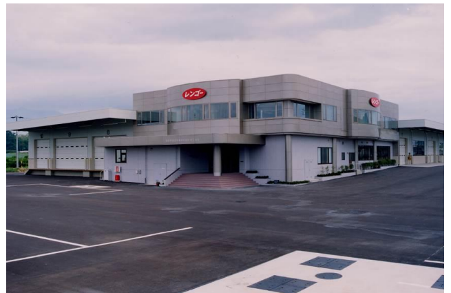
長野県連合青果(株) 佐久支社新築工事(JV) 〔構造〕鉄骨造 2階建
