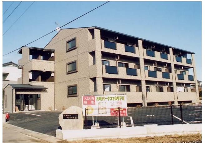
H様賃貸マンション新築工事 〔構造〕鉄筋コンクリート造3階建
