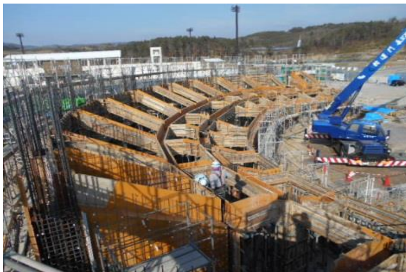
上記工事施工中
