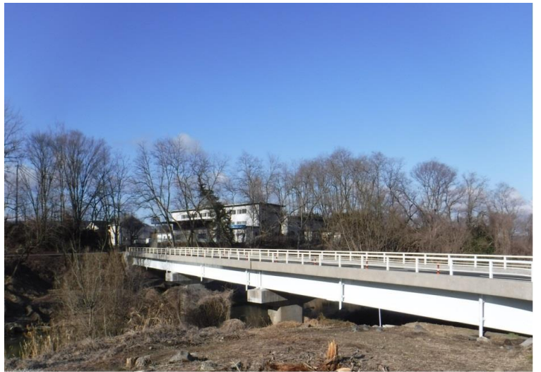
藤ノ木橋 橋梁補修工事
