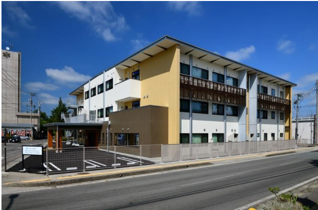
社会医療法人 恵仁会 サテライト老人保健施設建設工事 〔構造〕鉄骨造 3階建 〔規模〕延面積 2,088.04㎡
