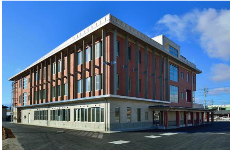
佐久広域連合消防本部 佐久消防署庁舎新築工事 〔構造〕鉄骨鉄筋コンクリート3階建 〔規模〕延面積 3880.79㎡
