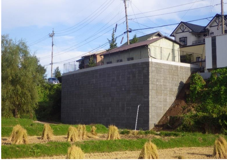
K様邸擁壁改修工事
