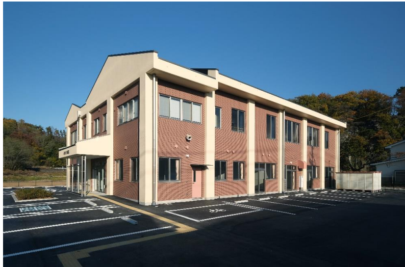
佐久市東会館改築(本体)工事 〔構造〕鉄筋コンクリート造 〔規模〕延面積 1,061㎡
