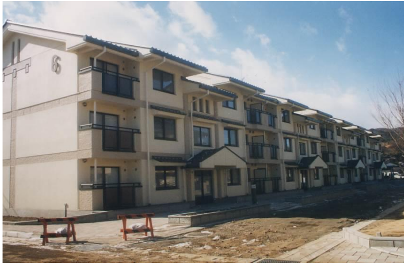
県営住宅泉団地6号棟建築工事 〔構造〕鉄筋コンクリート造 3階建
