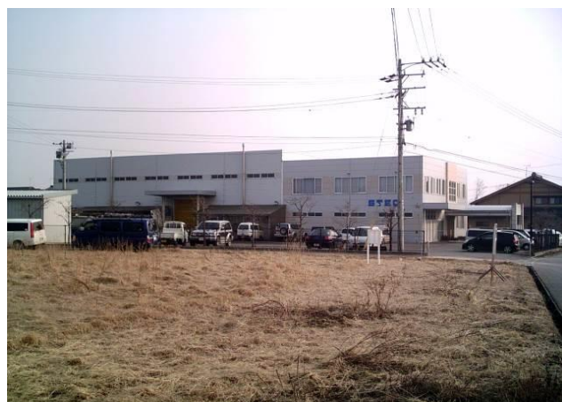
(株)ステック工場新築工事 〔構造〕鉄骨造 2階建
