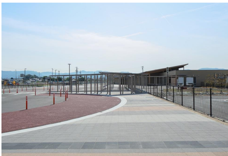
ヘルシーテラス佐久南 駐車場屋根・歩行者用屋外通路工事
