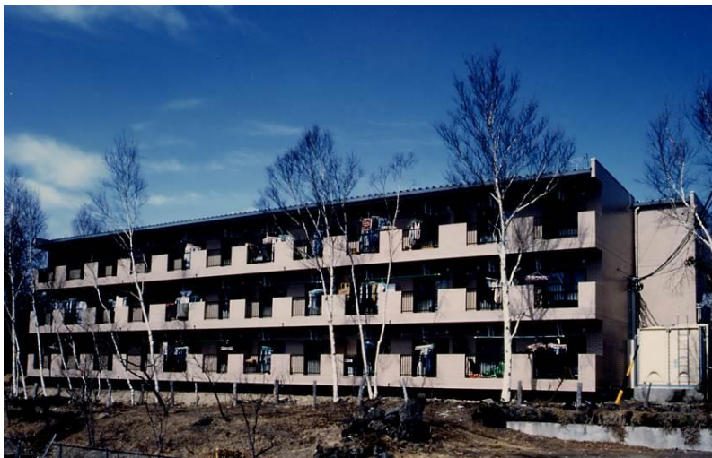
(株)ミヨタ第1浅間寮新築工事 〔構造〕鉄筋コンクリート造3階建
