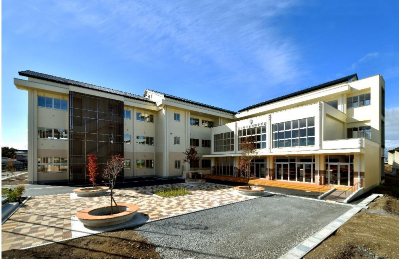
佐久市立岩村田小学校 普通特別教室棟改築(本体)工事 〔構造〕鉄筋コンクリート3階建 〔規模〕延面積 5,384㎡
