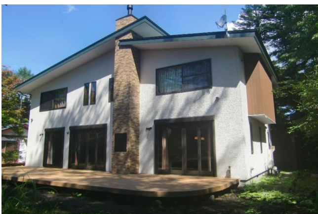
Y様別荘新築工事 〔構造〕木造 2階建
