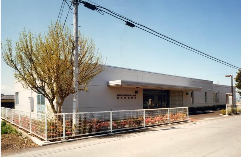
佐久検察支部建築工事 〔構造〕鉄筋コンクリート造 平家建
