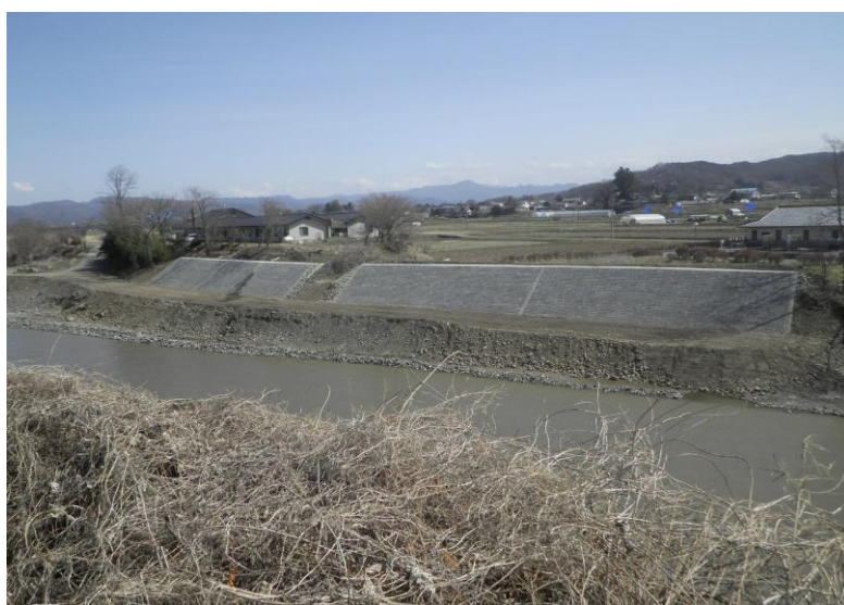
1 災公共土木施設災害復旧工事 (一)千曲川 佐久市 結の里千曲裏他(JV) 護岸ブロック工事
