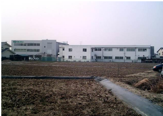
(株)ボンマーク管理工場棟増築及工場改装工事 〔構造〕鉄骨造 3階建
