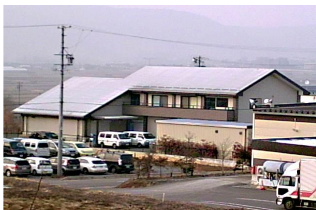
(有)南町伴野商店製麺工場新築工事 〔構造〕木造 2階建
