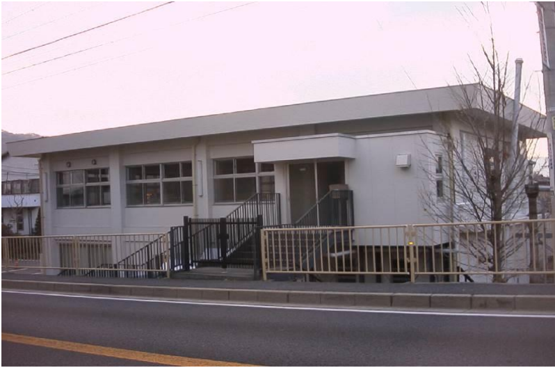
長野国道事務所 上田出張所耐震改修工事 〔構造〕鉄筋コンクリート造 2階建
