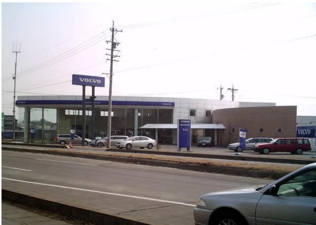
ヨコタ・インターナショナル西軽井沢店新築工事 〔構造〕鉄骨造 2階建
