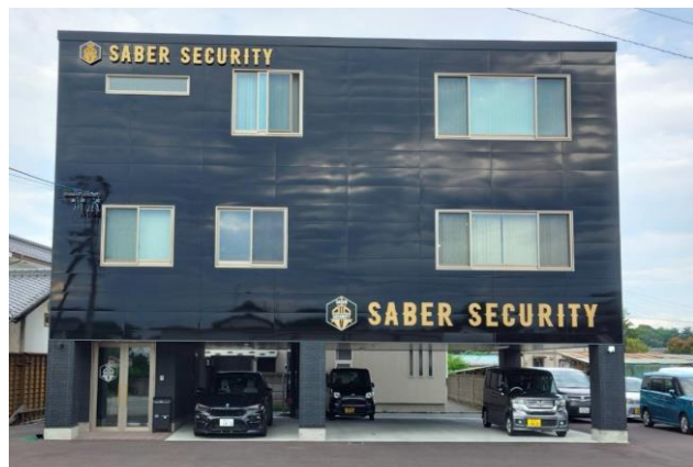
(株)セイバーセキュリティ新社屋新築工事 〔構造〕鉄骨造 2階建〔規模〕延面積 378.0㎡
