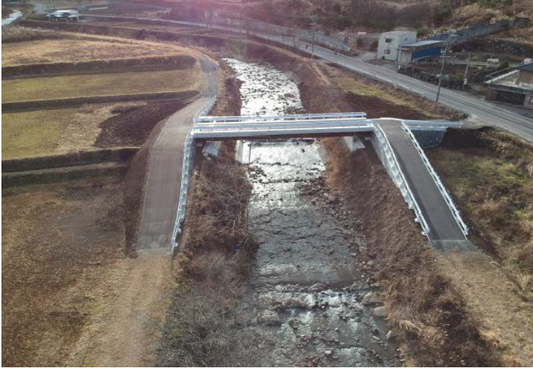
令和3年度 国補 令和元年東日本台風豪雨災害復旧事業 岩下(1)橋梁復旧工事
