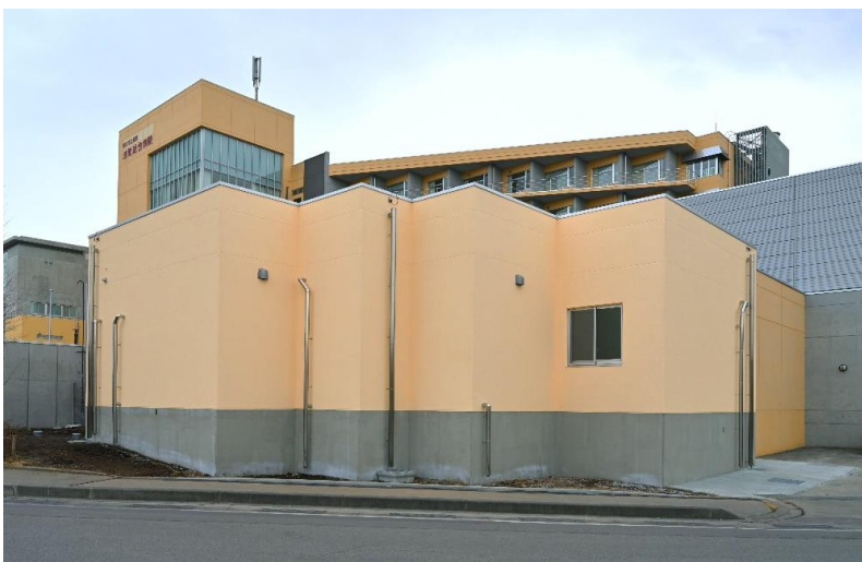
佐久市立国保浅間総合病院 循環器内科血管造影室増設工事 〔構造〕鉄筋コンクリート造 〔規模〕延面積 184.08㎡
