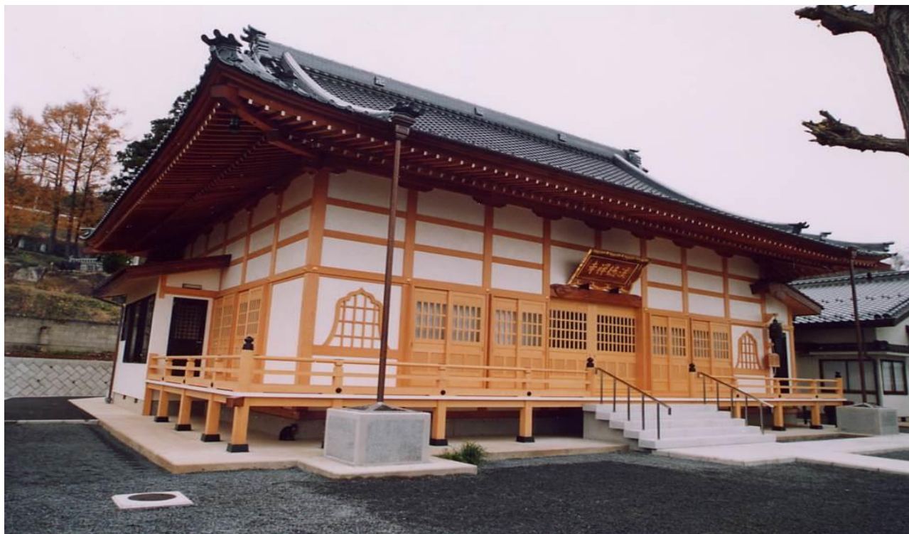
溪徳寺本堂建設工事 〔構造〕木造 平家建 〔延床面積〕211.7㎡(64坪)
