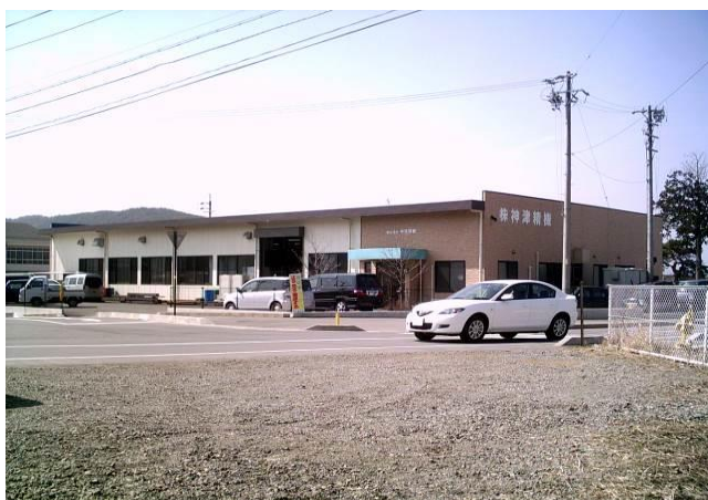
(株)神津精機工場新築工事 〔構造〕鉄骨造 平家建 〔規模〕延面積 751.81㎡
