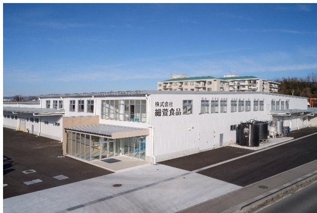
(株)細萱食品工場新築工事 〔構造〕鉄骨造 2階建〔規模〕延面積 4,811.8㎡
