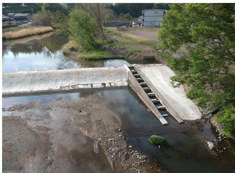
国補令和元年度東日本台風豪雨災害復旧事業 常木用水頭首工復旧工事
