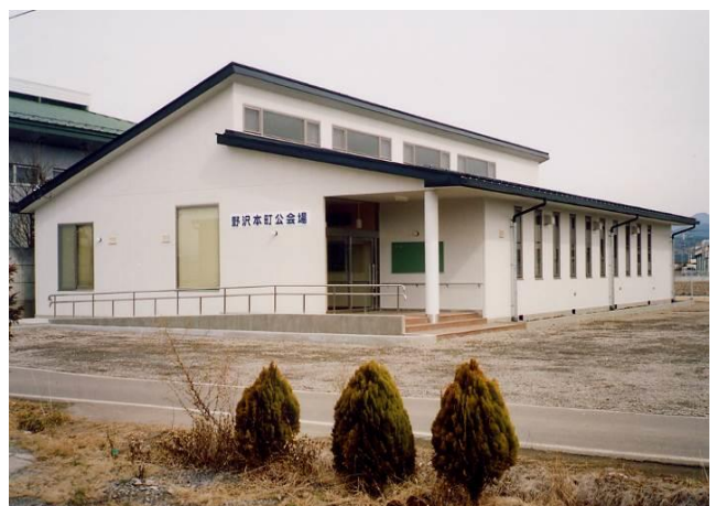
野沢本町区公会場建設工事 〔構造〕鉄骨造 平家建
